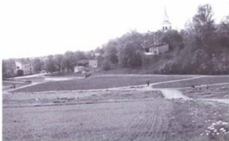
Källängen strax efter att anläggandet påbörjats, 1950-tal. Det våta området har fyllts ut och gångar har anlagts. (Vimmerby kommuns Ljud- och Bildarkiv)
