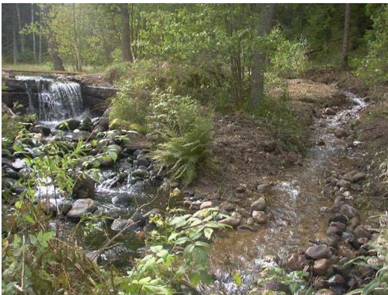
Vassbäckdammens utfall med det nya omlöpet till höger Foto: Björn Holm
