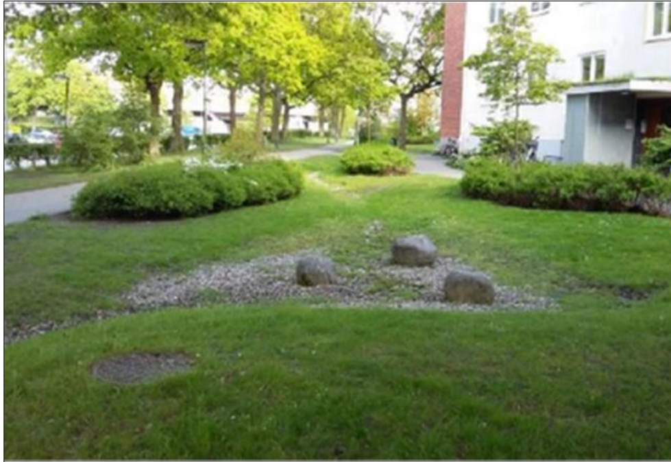
Torrdamm i Malmö. Bild: Sweco
