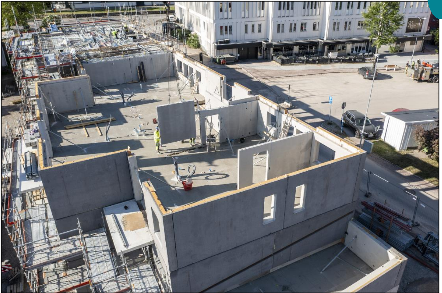
Vimarhems pågående byggnation av fastigheten Uven. Bilden tagen i juni 2023.
