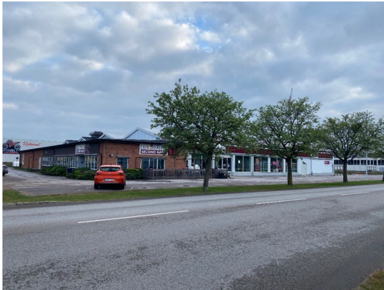
Figur 15. Vy från sydväst. Observera att rivning av byggnaden pågår under planarbetets gång.
