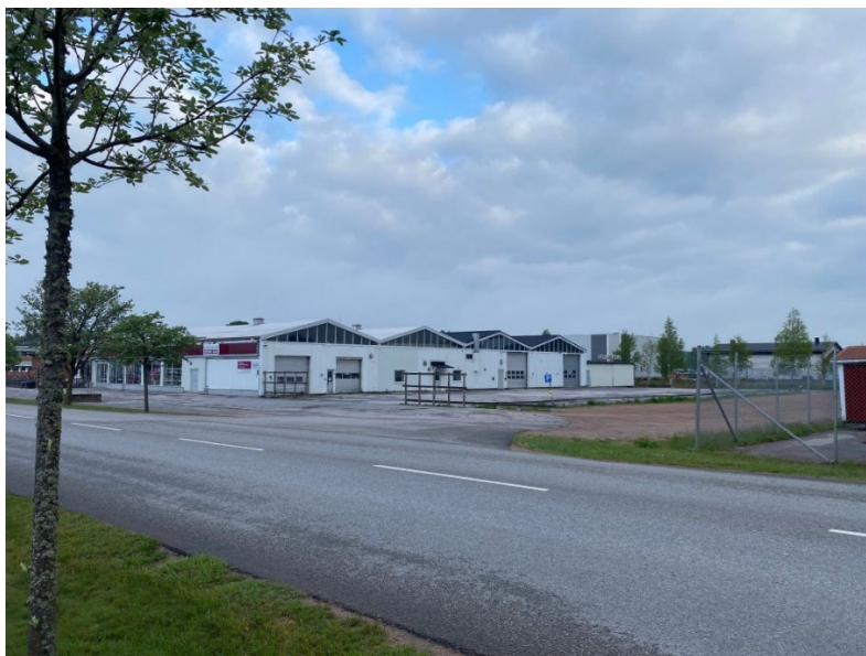
Figur 16. Vy från sydöst. Observera att rivning av byggnaden pågår under planarbetets gång.
