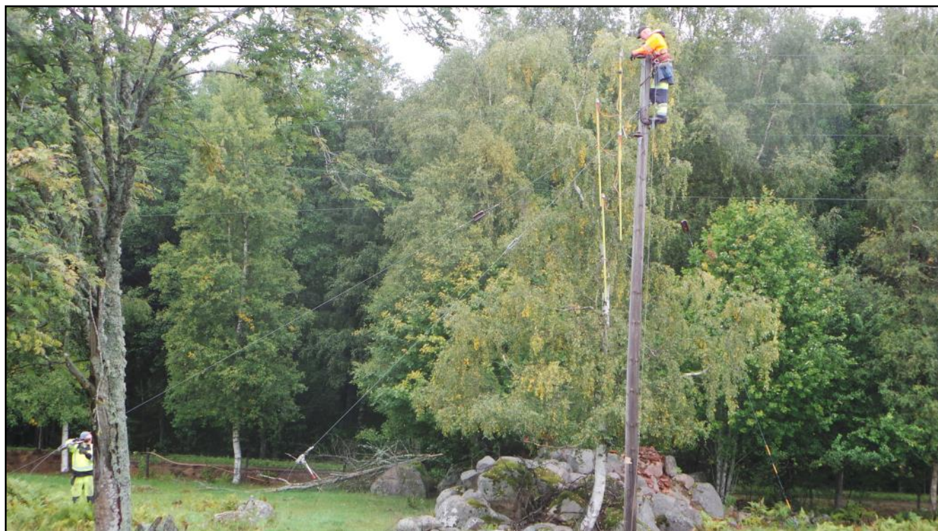
Reparation av elledningar utförs av Vimmerby Energi & Miljö AB Foto: Marika Andersson
