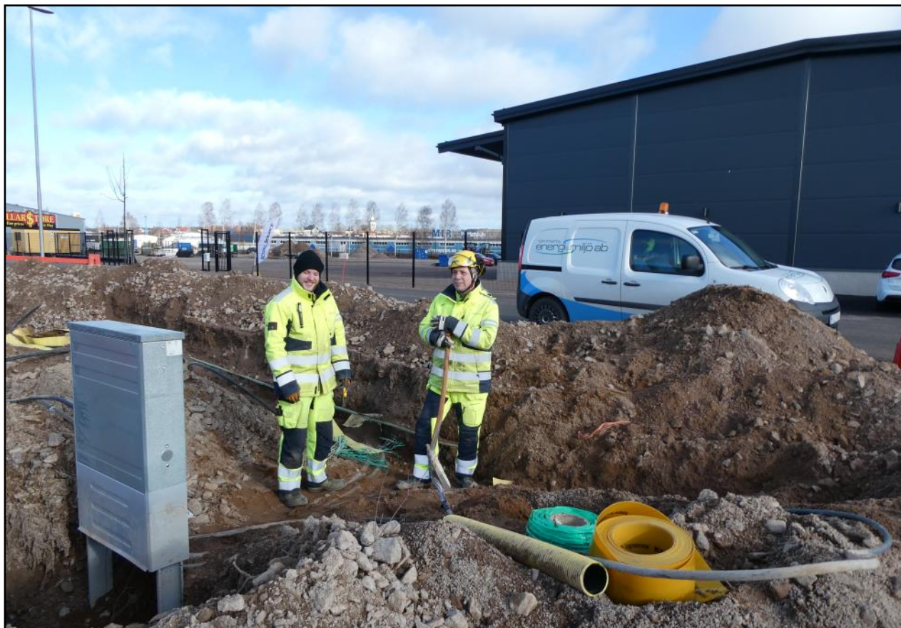
Grävning utförs av Vimmerby Energi & Miljö AB Foto: Marika Andersson
