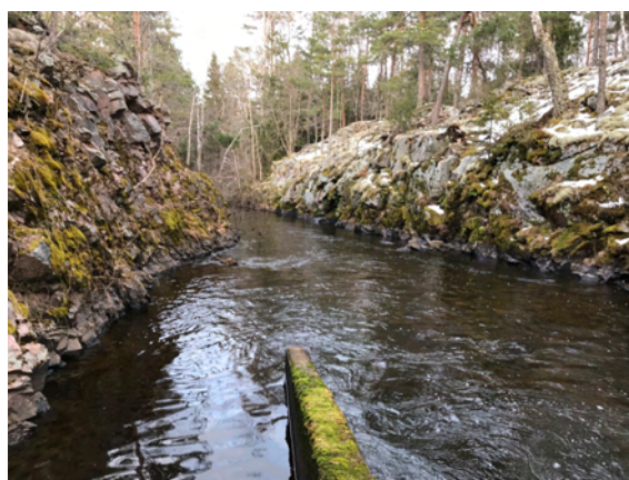
Yxeredsåns start omedelbart nedanför regleringsdammen. Den sprängda kanalen är 10 meter bred och 3-6 meter hög, och 60 meter lång.
