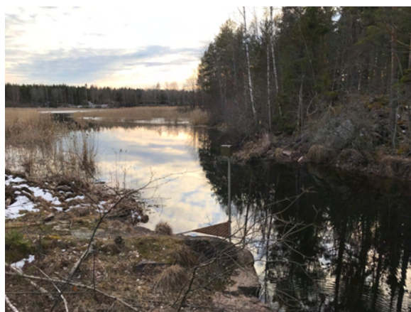
Åviken i Yxern med automatisk avläsning av vattenstånd i sjön nära regleringsdammen vid utloppet. Vid tillfället var vattenståndet 91,49.
