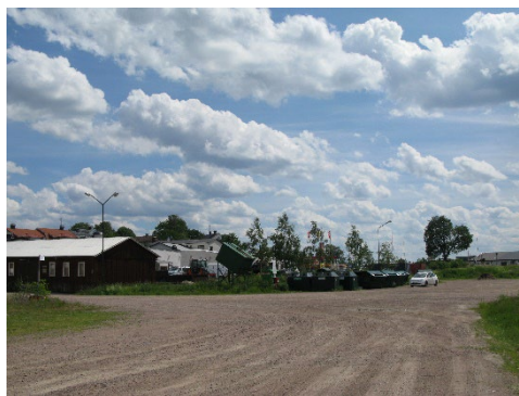
Kommunalt förråd samt Återvinningsstation
