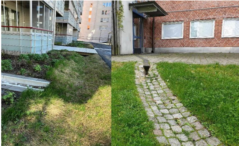
Vänster: Avledning av takvatten via lökrännor och svackdike med gångbro av trä. Höger: Avledning av takvatten via kullerstensbelagt skålformat dike.
