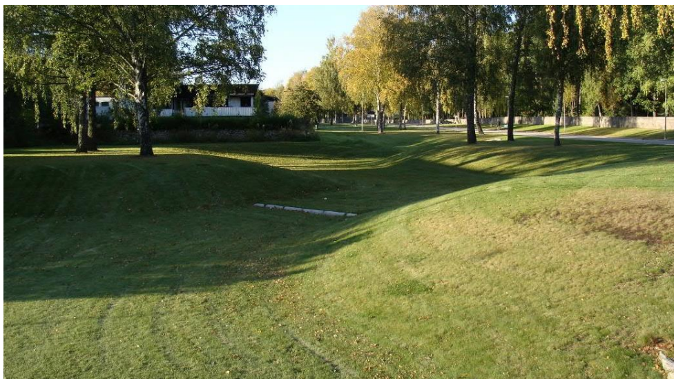
Exempel öppen dagvattenfördröjning (dagvattenutredning, WSP)
