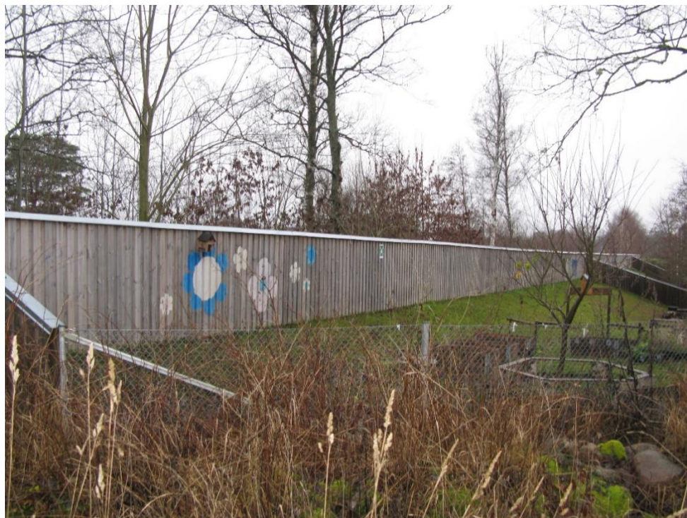
foto, Vimmerby kommun: Del av bullervall med skärm/plank mot RV40.
