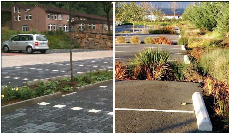
Regnbäddar på parkering. Bild: Sweco
