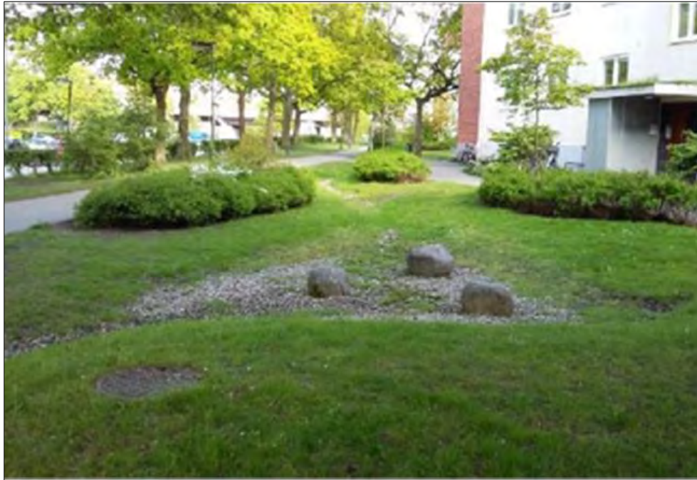
Torrdamm i Malmö. Bild: Sweco
